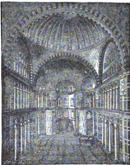
Fig. 2. — La Chiesa di S. Sofia a Costantinopoli.
